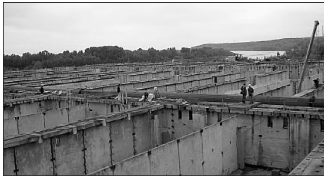
Строительство блока № 4 биологической очистки стоков.
